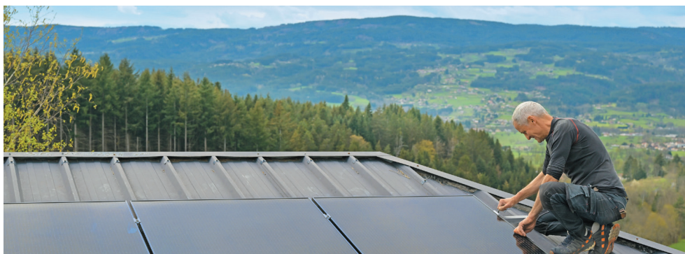
Pose de panneaux photovoltaïques © Joël DAMASE
