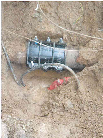
Photo d'un manchon de réparation
