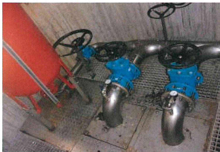
Photos de l'intérieure du Puits de Captage des Gravières à Pont du Château Profondeur de l'ouvrage : 7 m environ Pompage dans la nappe alluviale de l'Allier
